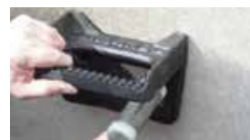
3. Insérer le goujon dans le trou de l'échelon en utilisant l'outil de frappe
