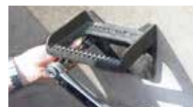
6. Serrage à l'aide d'une clé dynamométrique ( T_{inst} = 25 \text{ Nm} )
