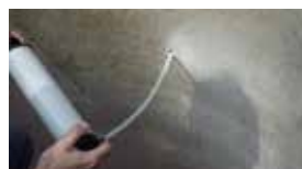
2. Nettoyer le trou de perçage
