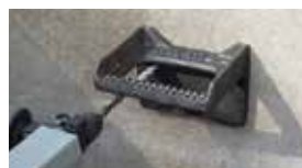
5. Créez un deuxième trou de perçage et nettoyez-le. L'échelon sert de gabarit de perçage.
