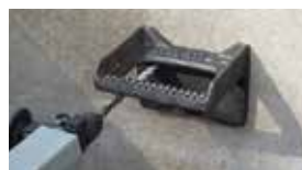
5. Créez un deuxième trou de perçage et nettoyez-le. L'échelon sert de gabarit de perçage.
