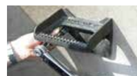
6. Steigeisenanker setzen und mit Drehmomentschlüssel T_{inst} = 25 \text{ Nm} aufbringen.
