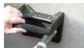
3. Insérez l'ancrage du crampon dans le trou du crampon en utilisant la méthode de l'enfoncement.
