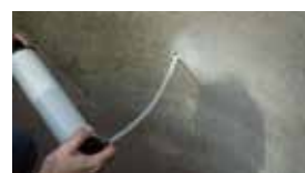
2. Nettoyer trou de perçage
