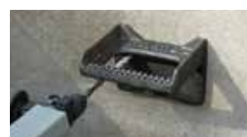
5. Créez un deuxième trou de perçage et nettoyez-le. Le crampon sert de gabarit de perçage.
