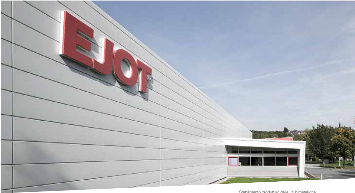
Stabilimento produttivo delle viti bimetalliche Sede „In der Aue“, Bad Laasphe (Germania)
